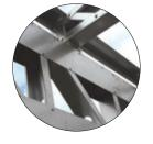
Applications à forte charge pour les sections industrielles, commerciales et résidentielles avec une capacité de gros calibrage allant jusqu'à une épaisseur TCT de 2 mm (14 g).
