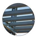
Les solives se situent au même niveau que les poutrelles périmétriques, ce qui permet un transfert de charge complet pour des structures modulaires et à niveaux multiples, procurant ainsi robustesse et fiabilité.
